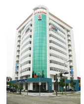
Cty CP Xây lắp TT Huế
